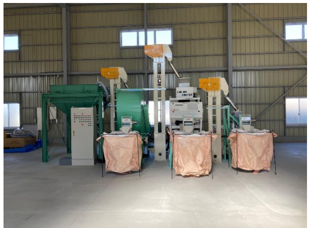
ガラス精製設備
