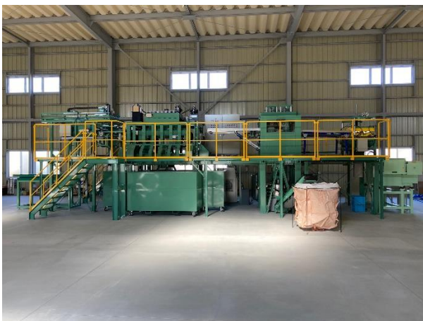
わけーる設備
